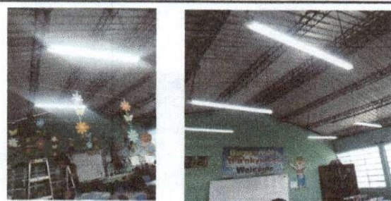
Foto 5: Sustitución de lamparas de 2 x 40
