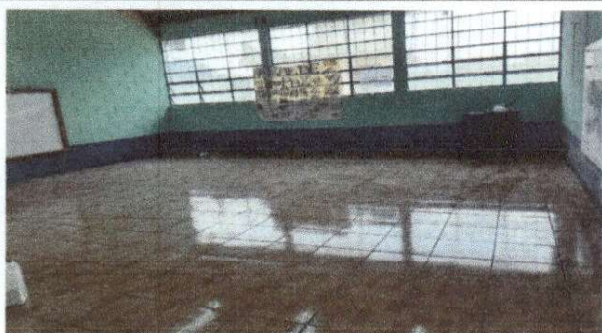
Foto1: Sustitución de piso Ceramico
