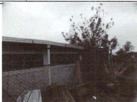
Foto 2: Sustitución de canal de pvc
