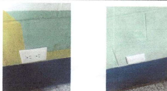
Foto 6: Sustitución interruptores dobles
