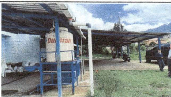
Foto 3: Reparación de bajada de agua pluvial, tubo de pvc 3"
